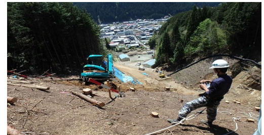
工事種類：砂防工事 施工地域：岐阜県郡上市
