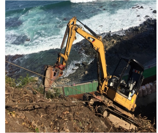
工事種類：法面改良工事 施工地域：福岡県福岡市
