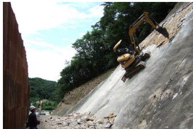
工事種類：国道拡幅改築工事 施工地域：島根県大田市
