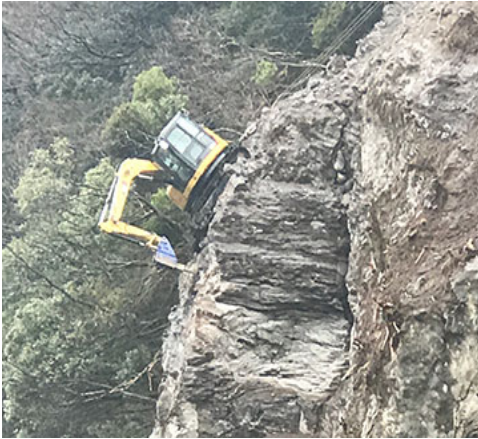
工事種類：災害復旧道路補修工事 施工地域：熊本県阿蘇郡
