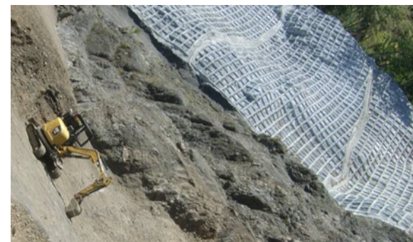
工事種類：復旧治山工事 施工場所：静岡県榛原郡
