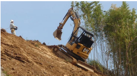
工事種類：急傾斜地崩壊防止施設災害復旧工事 施工地域：和歌山県海南市
