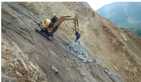
工事種類：復旧治山工事 施工地域：長野県北安曇郡
