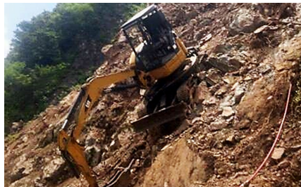
工事種類：山腹法面工事 施工場所：新潟県糸魚川市
