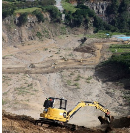
工事名称：斜面对策工事 施工地域：熊本県阿蘇郡
