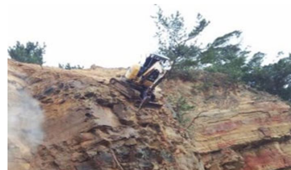
工事種類：公園法面改修工事 施工地域：福岡県福岡市
