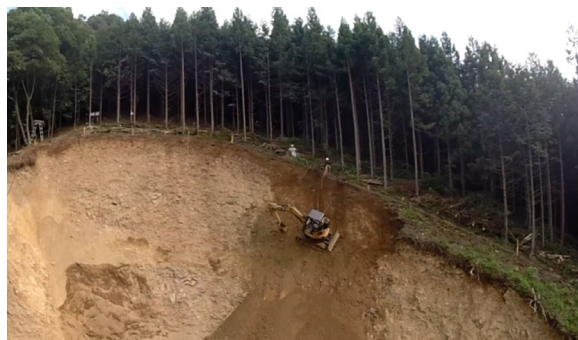
工事名称：治山工事 施工地域：山梨県大月市
