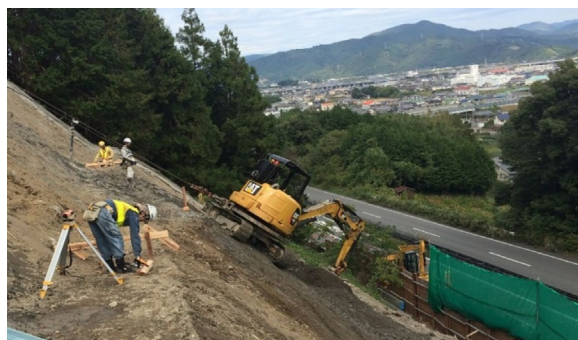
工事種類：国道法面修繕工事 施工地域：静岡県島田市
