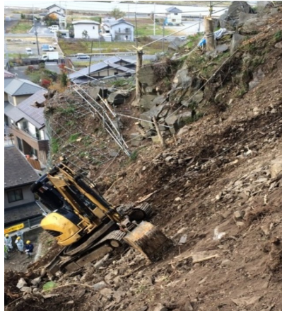
工事名称：保安林保全工事 施工地域：宮城県石巻市
